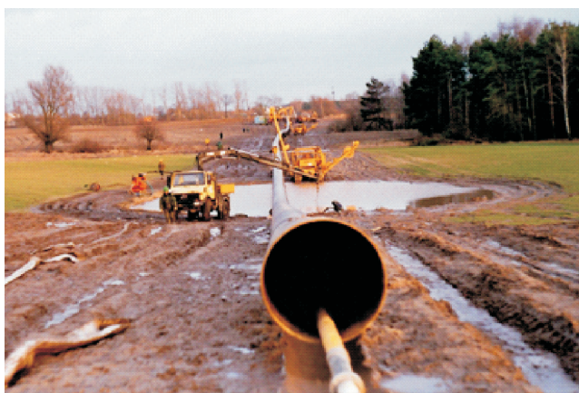
Rys. 1. Instalacja rurociągu (źródło: archiwum autora)
