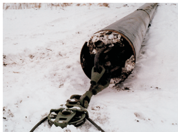
Rys. 2. Instalacja rurociągu w zimie (źródło: archiwum autora)
