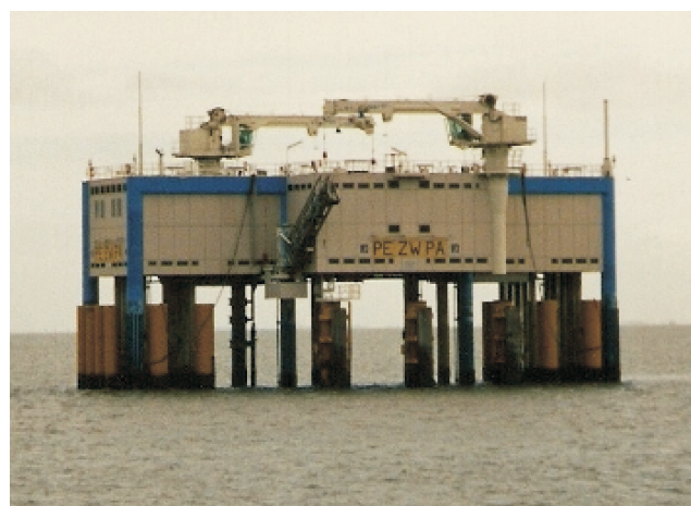
Fot. 2. Platforma do wydobywania gazu u wybrzeży Norwegii
