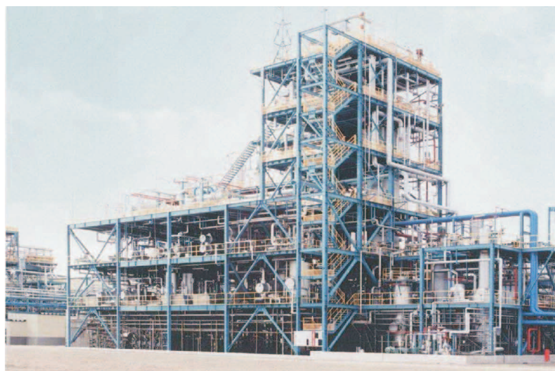
Rys. 11. Demonstracyjna instalacja NKK Corporation do produkcji DME, o wydatku 100 t/dobę (Kushiro, Japonia), według de Mestier du Burg H. [3]
