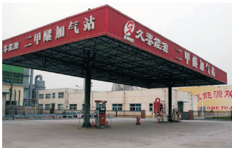
Rys. 7. Stacja paliwowa DME (Shanghai Diesel Engine Co., Chiny)
