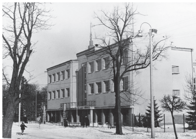
Budynek Domu Robotniczego w Krośnicach, siedziba Szkoły Naftowej [4] (arch. MPNiG w Bóbrce)
